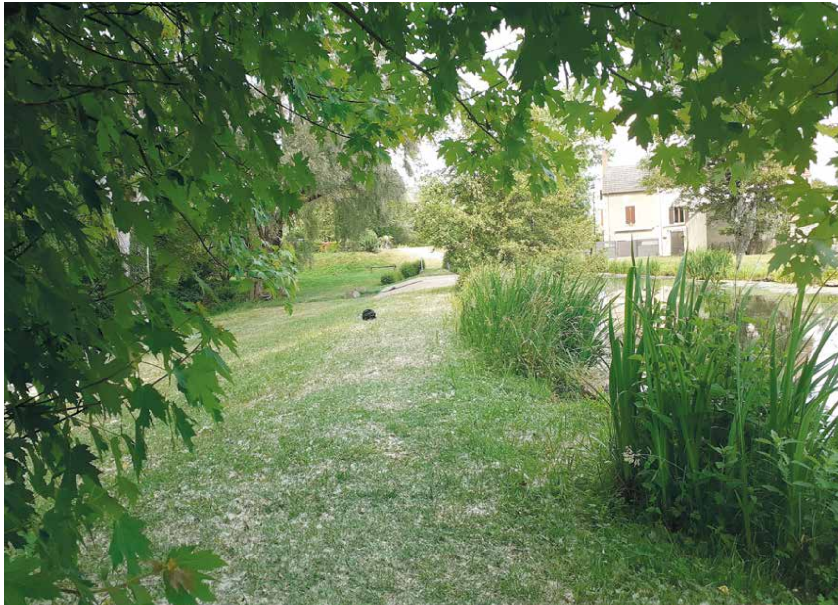
Déversoir sur l'Aubois, commune de Chautay
